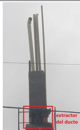
Fotografía 18. Ducto de descarga con instalación de ductos en PVC en el desfogue Cuatro Ductos de PVC
